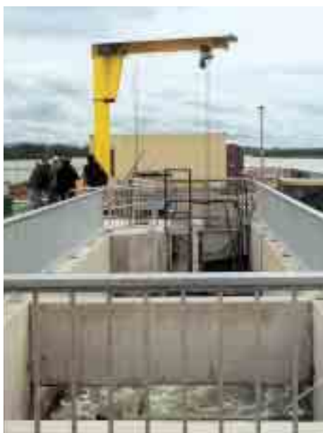
Le Rhin : les travaux d'Hercule
